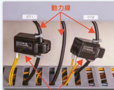
無需改變線路即可將交流電流傳感器安裝到既有的動力線上。
